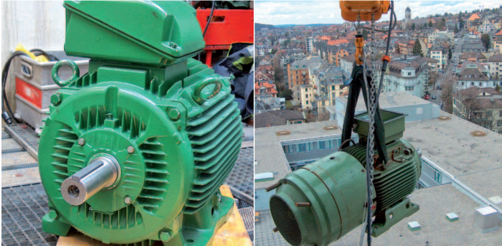
Weniger Verbrauch: Ein 16 Jahre alter Motor wird gegen einen energieeffizienten neuen ausgetauscht. (Bilder Wolfgang Seifert/ETH Zürich)
